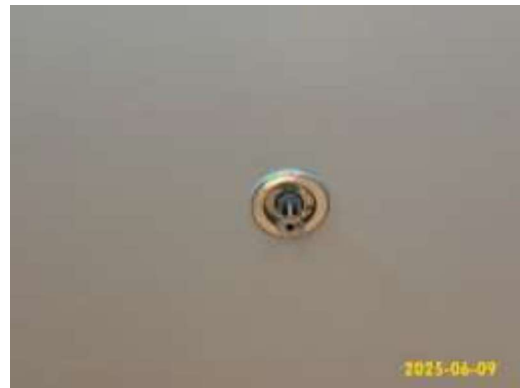
หัวกระจายน้ำอัตโนมัติ (Sprinkler)
