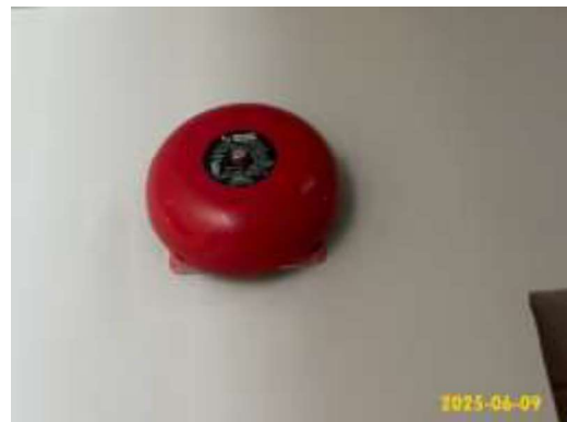
อุปกรณ์ส่งเสียงสัญญาณแจ้งเหตุ (Alarm Bell)
